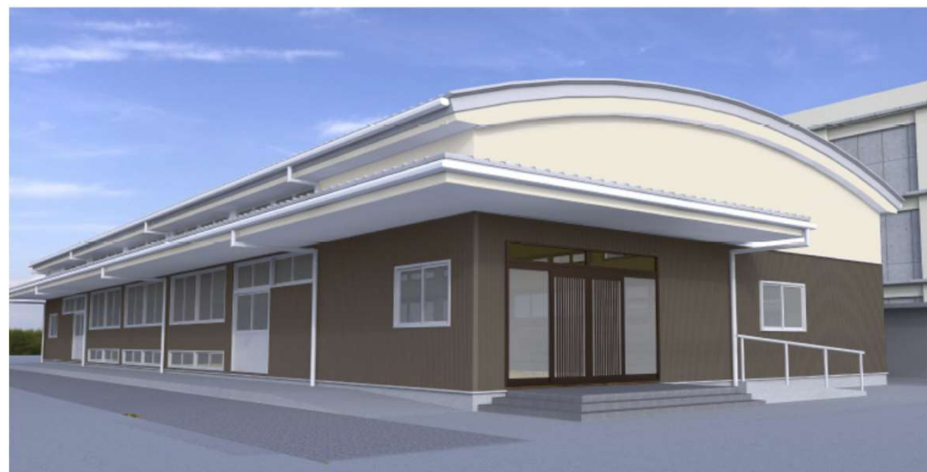
2023年春 新武道場「至道館」竣工
